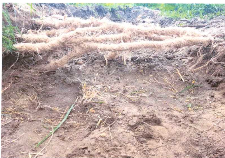
Ryc. 12. Korzenie drzewa odsłonięte w wykopie, zabezpieczone przez prawidłowe „odłożenie” i owinięcie tkaniną jutową.
