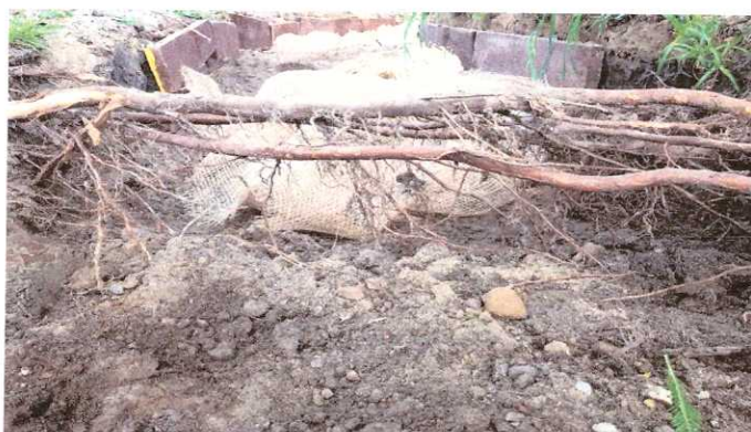
Ryc. 11. Poglądowa fotografia prowadzenia wykopów z zachowaniem korzeni drzew. Prace wykonane zostały niestaranie (odarcie warstwy korowicy i łyka). Korzenie powinny zostać okryte zwilżaną tkaniną jutową jak na Ryc. 4. Źródło: https://siedem-wierzb.pl/korzenie-drzew-podczas-prac-ziemnych-jak-chronic/
